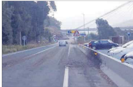
Los restos de lodos en la PO-551 y coches salpicados. // FdV
